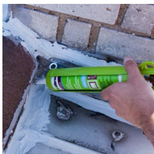
1. Aplicarea membranei din cartuș.
